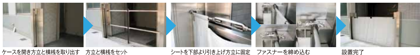
ケースを開き方立と横棧を取り出す 方立と横棧をセッ シートを下部より引き上げ方立に固定 ファスナーを締め込む 設置完了
