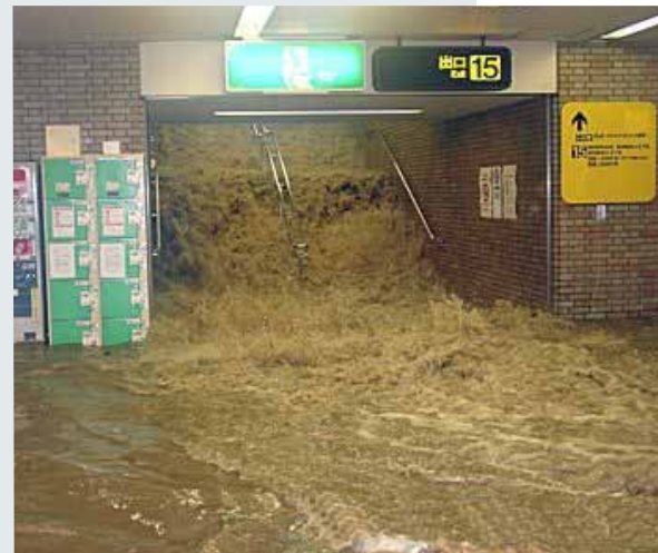
福岡市営地下鉄大水害
